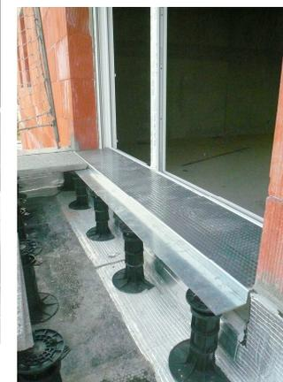
Le caillebotis universel est particulièrement destiné à l'ensemble des portes fenêtres des balcons, des loggias et des terrasses réalisés en dalle (gravillonnée, bois) ou lames bois sur lambourdes pour tous les bâtiments répondant à l'accessibilité handicapé.
